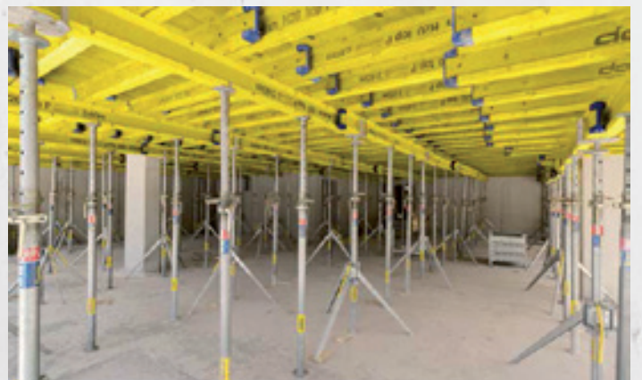
Die Schalungsplatte 3S basic wird als wirtschaftliche Schalhaut bei Dokaflex-Deckenschalungen eingesetzt.
